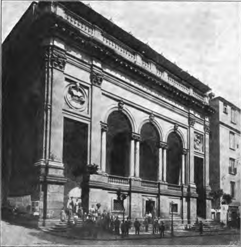
Vorhalle der Sapienza zu Neapel.
